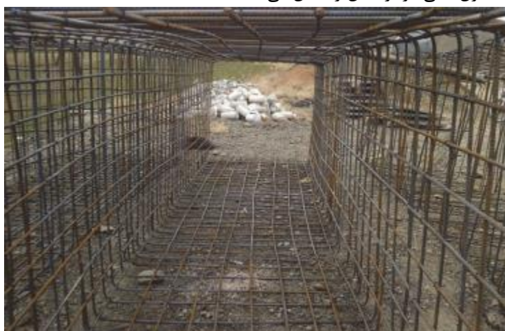
شکل ۲: آرماتوربندی سازه بتنی در مدل آزمایشگاهی
