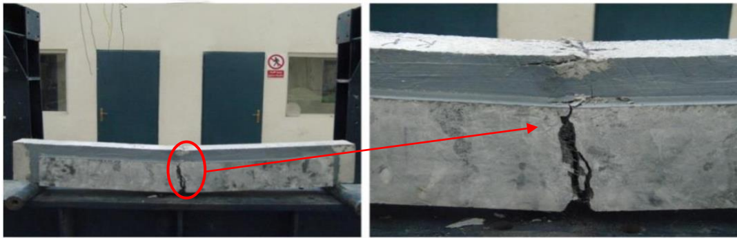
شکل ۹ نحوه ترک خوردگی تیر تقویت شده از نوع B-re
